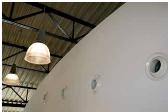
▲ De verse lucht kan via een schakeling tussen zaal en foyer (via nozzles) worden ingeblazen, al naar gelang waar de mensen zijn.
