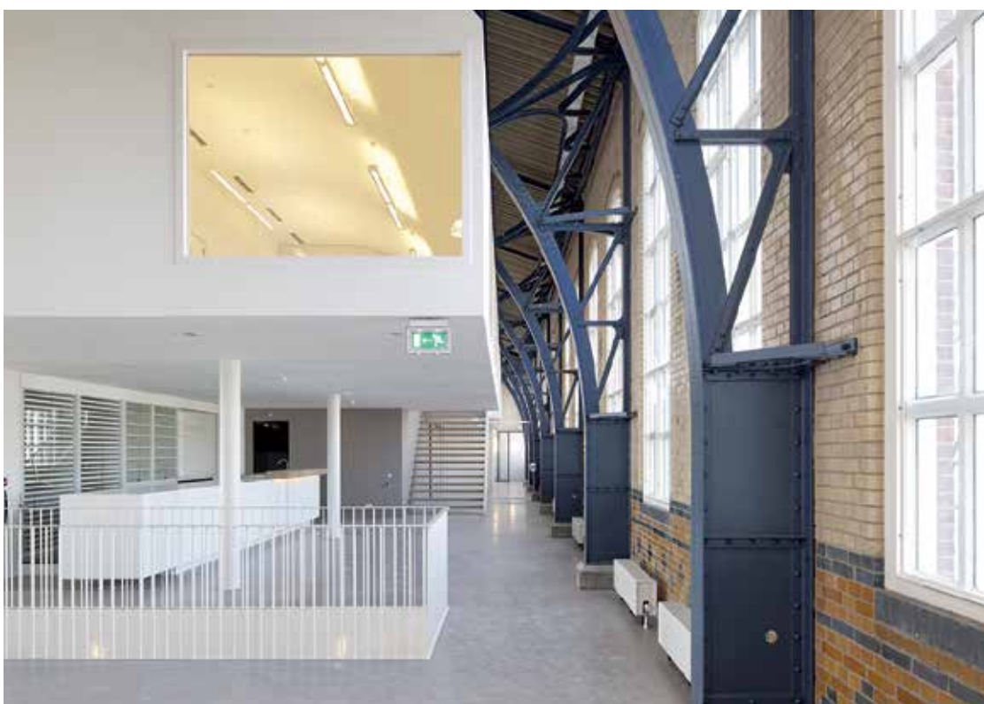
▲ Het principe van een doos-in-doostructie bleek de oplossing voor het programma en de installatietechniek.
