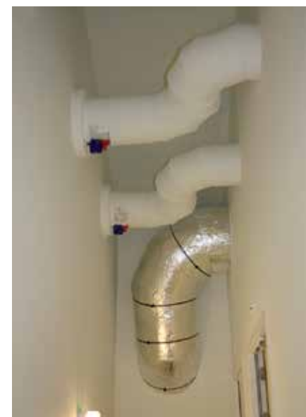
▲ De kanalen voor de installatietechniek zijn slechts sporadisch zichtbaar op de eerste en tweede verdieping.
