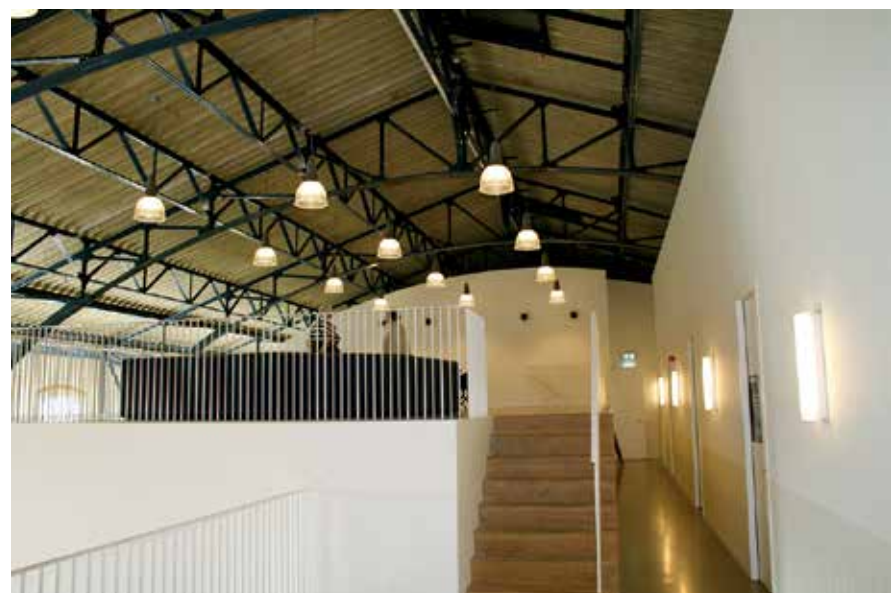
▲ Op de doosconstructies is extra vloeroppervlakte gecreëerd, met dank aan de grote hoogte.
